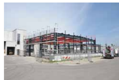
Baustelle Anfang Juni 2014
