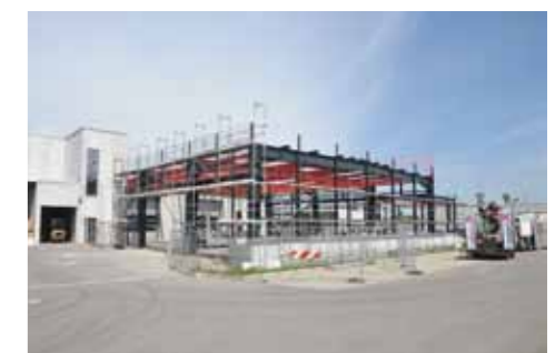
Baustelle Anfang Juni 2014
